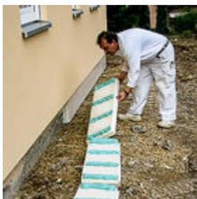
Zum Verlegen von Dämmstoffplatten im Perimeter-, Flachdach-, Keller- oder Wandbereich verlegt werden.
