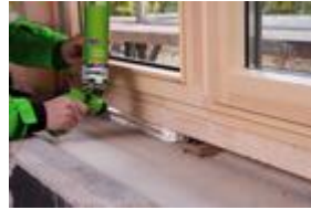
Verarbeitung der Fensteranschlussfuge mit FM220.
